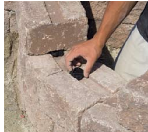
LE SYSTÈME D'ANCRAGE «FORTERESSE» PERMET LA POSE DE MURETS EN LIGNE DROITE, EN LIGNE COURBÉE OU EN ESCALIER. PARFAIT POUR TOUT TYPE D'AMÉNAGEMENT.
